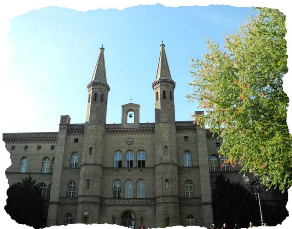
Ein Teil des Bethanien-Gebäudes in Berlin
