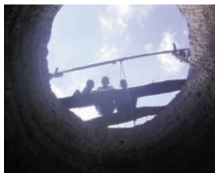
5 m Tiefe: Trotz simpler Werkzeuge geht der Brunnenbau schnell voran
